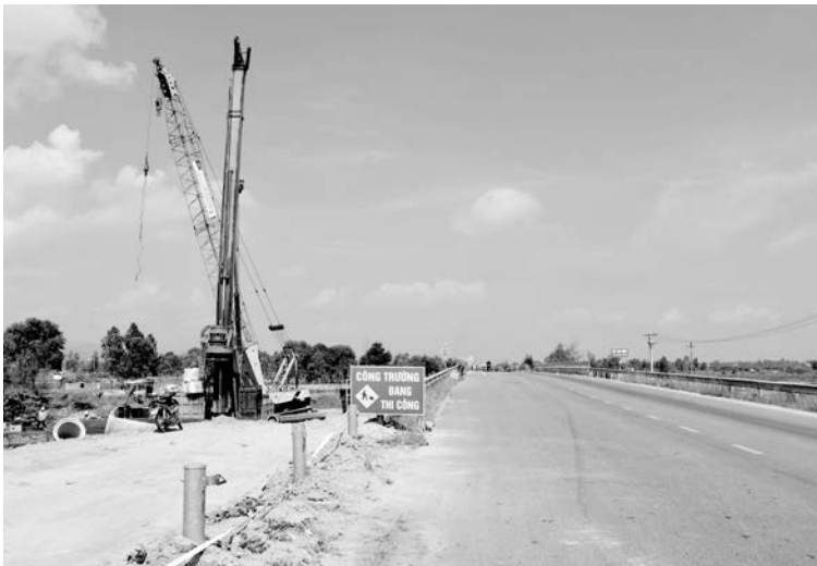
Thời gian qua, tỉnh Quảng Nam (cũ) đầu tư nhiều công trình hạ tầng giao thông trọng điểm. TRONG ẢNH: Đường Võ Chí Công tiếp tục hoàn thiện.
